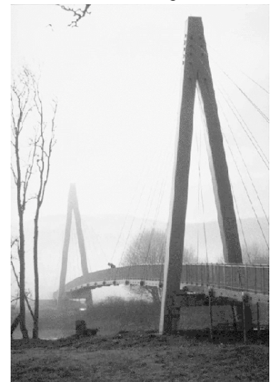
Passerelle d'Aberfeldy (photo Maunsell)
