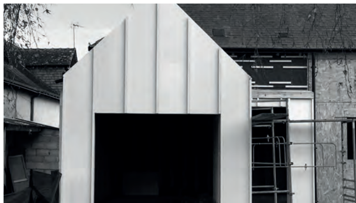
Agrandissement d'une maison en WALL E+® en cours de réalisation
