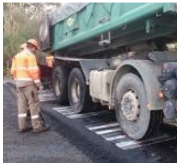
FIGURE 5 : A) CONSTRUCTION DES PLANCHES EXPÉRIMENTALES, B) GRILLE COMPOSITE, C) ESSAI DE FATIGUE AVEC SUIVI EXTENSOMÈTRE LASER.
